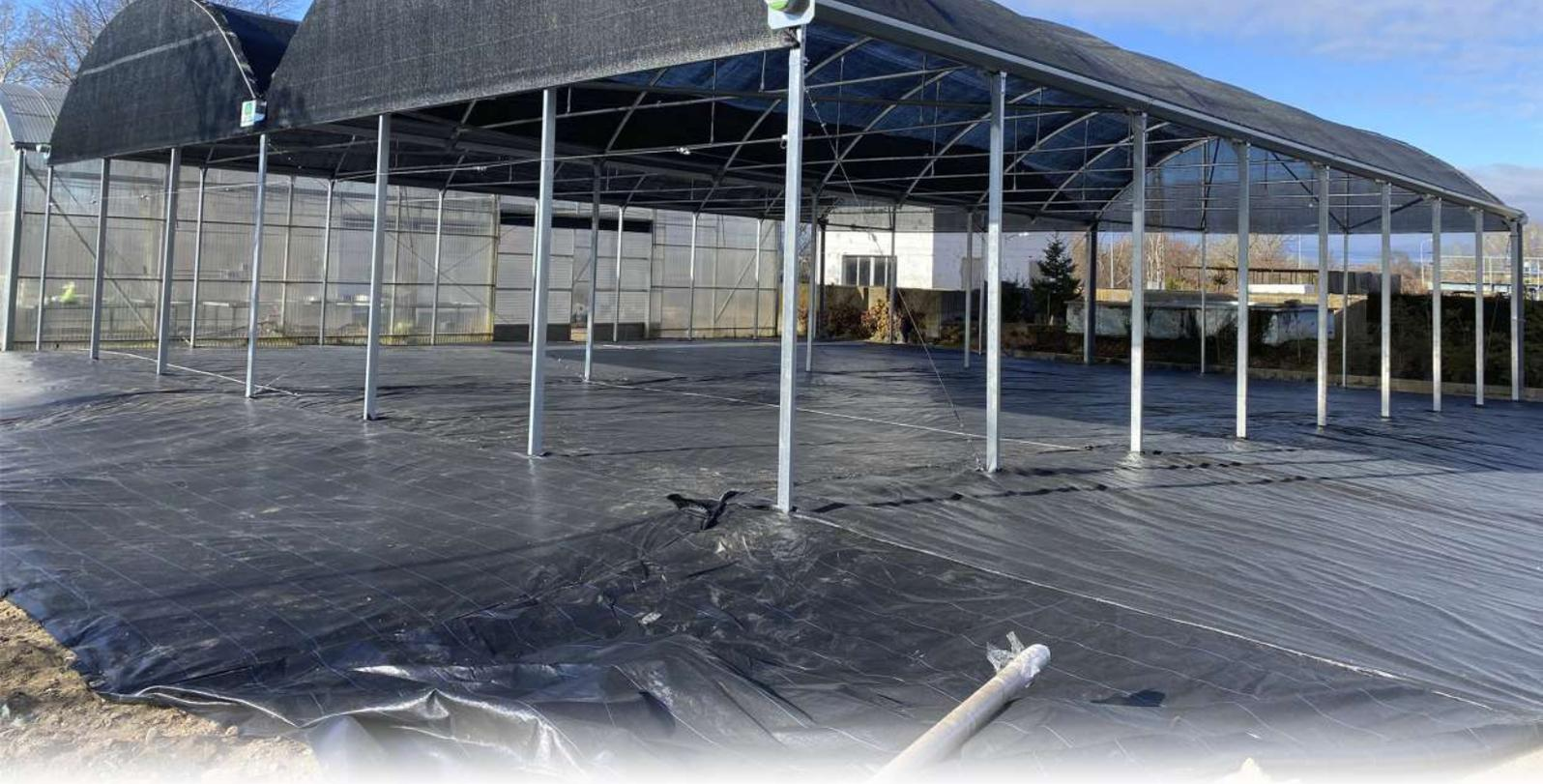
Este tipo de umbráculo mantiene la misma estructura que el invernadero multitúnel, diferenciándose en el tipo de cubierta.
