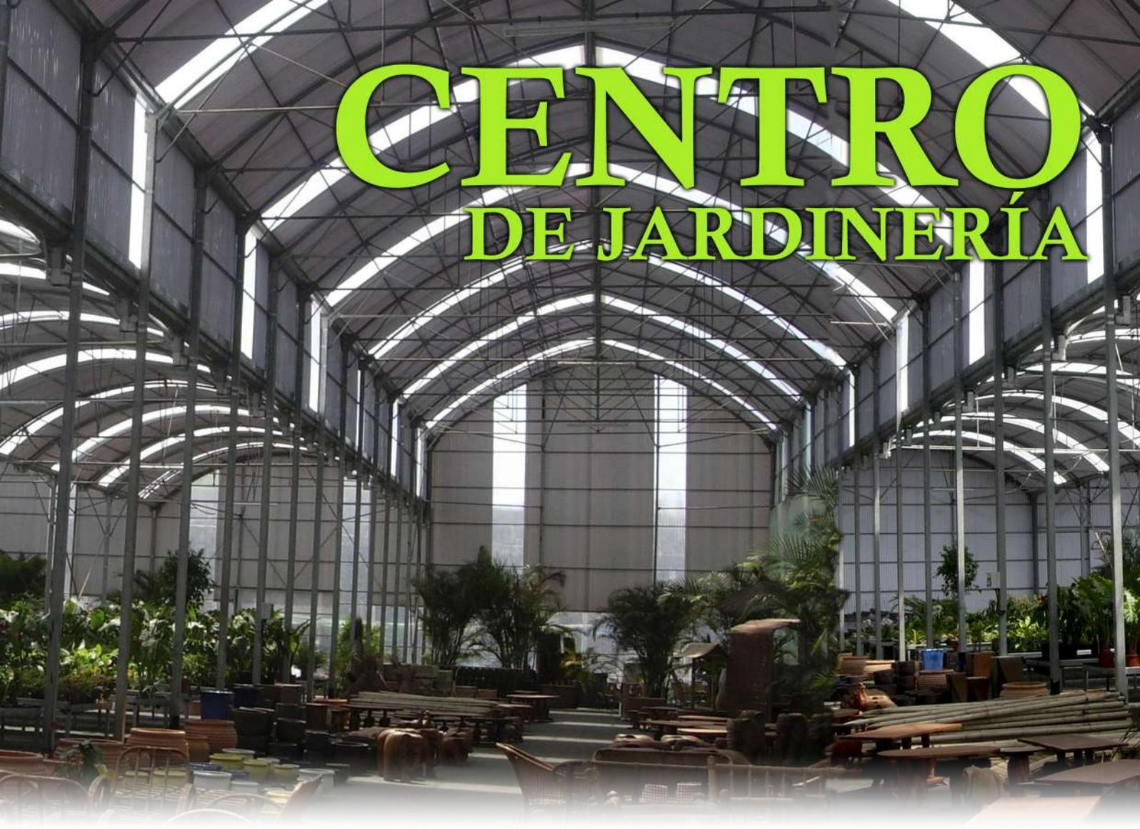
En este tipo de usos, los cerramientos suelen ser rígidos y normalmente más resistente y opacos. Nuestros centros de jardinería tienen la estructura de invernadero multitúnel, con la diferencia del tipo de cerramiento.
